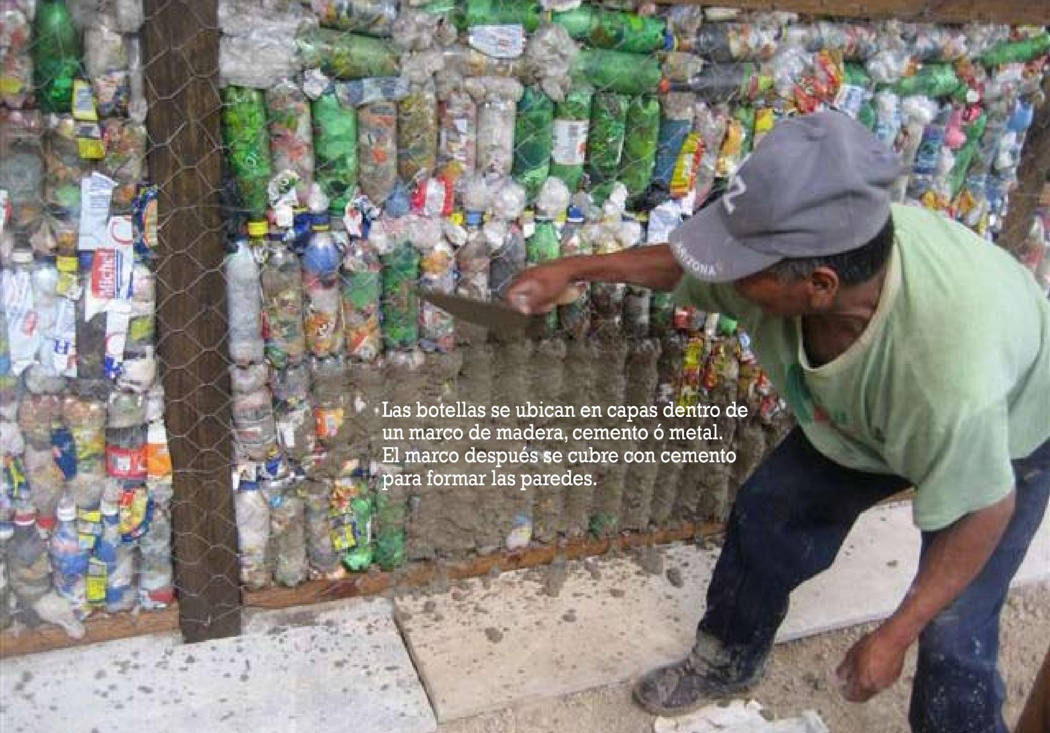
Las botellas se ubican en capas dentro de un marco de madera, cemento ó metal. El marco después se cubre con cemento para formar las paredes.
