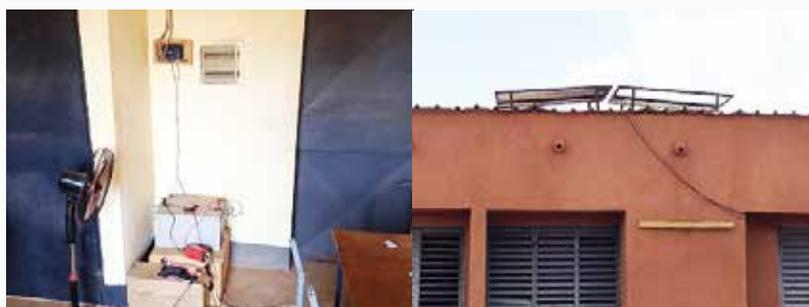
batteries solaires, cablages, et panneaux solaires
